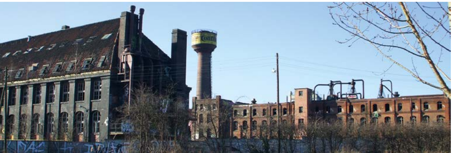
Ungenutzte Fabrikationshallen vor ihrem Abriss 2008
