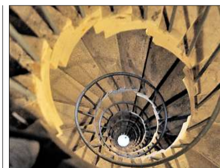
Mühevoller Aufstieg: Geschwungen windet die Treppe in der Säule nach oben.
