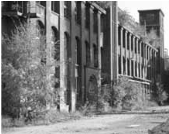
3 | Produktionsgebäude des Continental-Werks im September 2008, inzwischen abgerissen.
