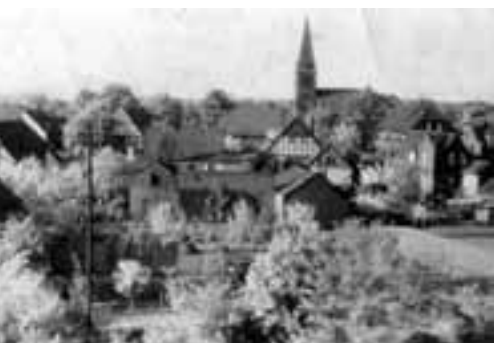
11 | Blick aus dem Haus Wunstorfer Straße 76 in den 1930er-Jahren
