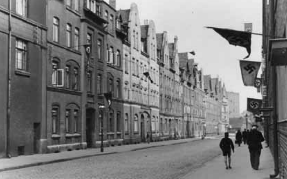
24 | Die Varrelmannstraße in Limmer mit Blick auf die Wunstorfer Straße am 20.04.1939
